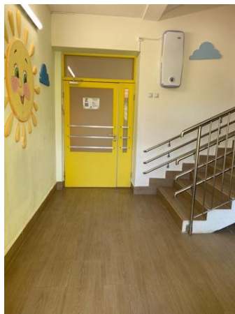
Фото 4 - Вход (входы) в здание - Входная площадка (перед дверью) - Дверь (входная) - Тамбур
