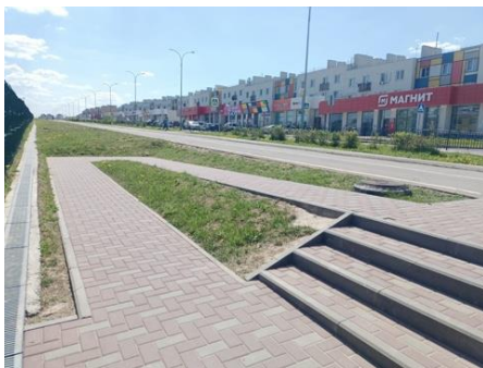
Фото 1 Территория, прилегающая к зданию (участок)
