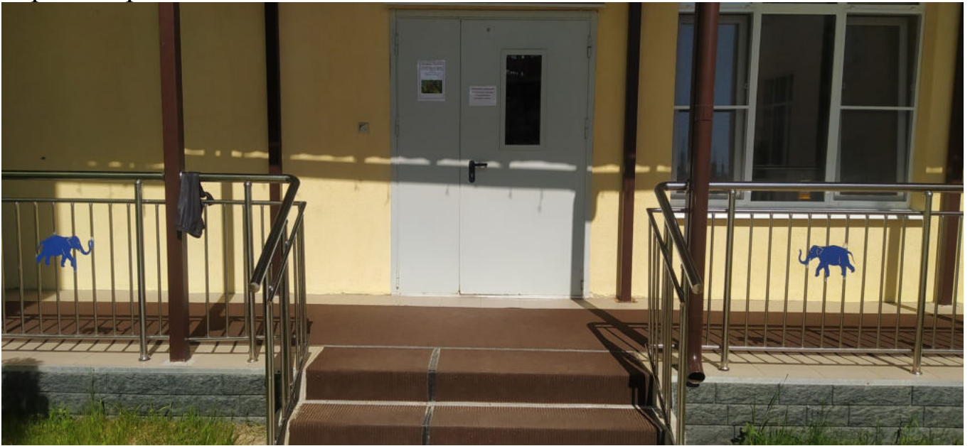
№ 4 Входная дверь (центральная) с наружной лестницей и площадкой перед дверью
