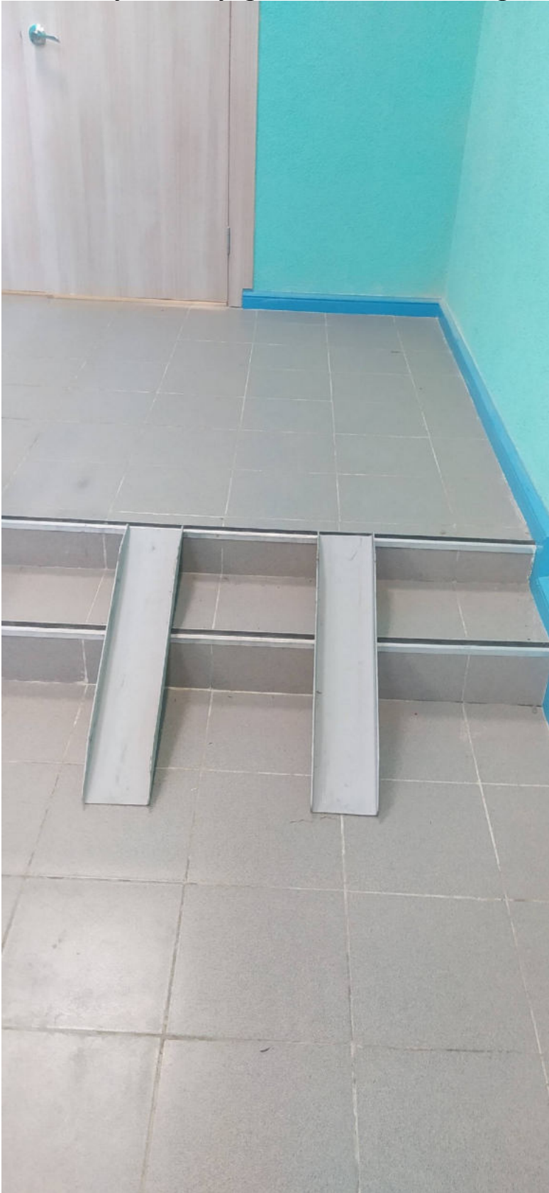
№9 пандус на внутренней лестнице первого этажа
