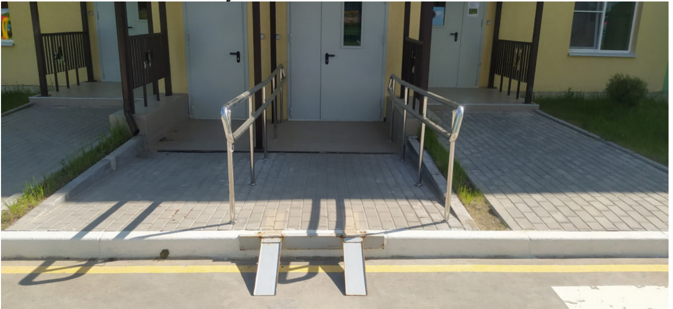
№3 Вход в здание с пандусом для колясок
