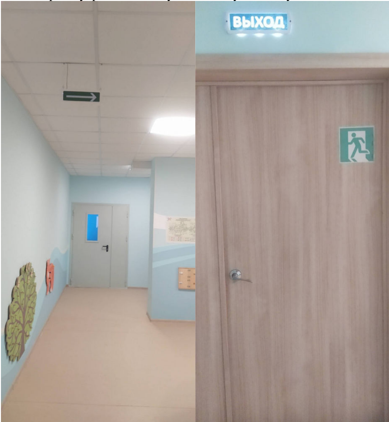
№10 двери внутри объекта и указатели путей эвакуации
